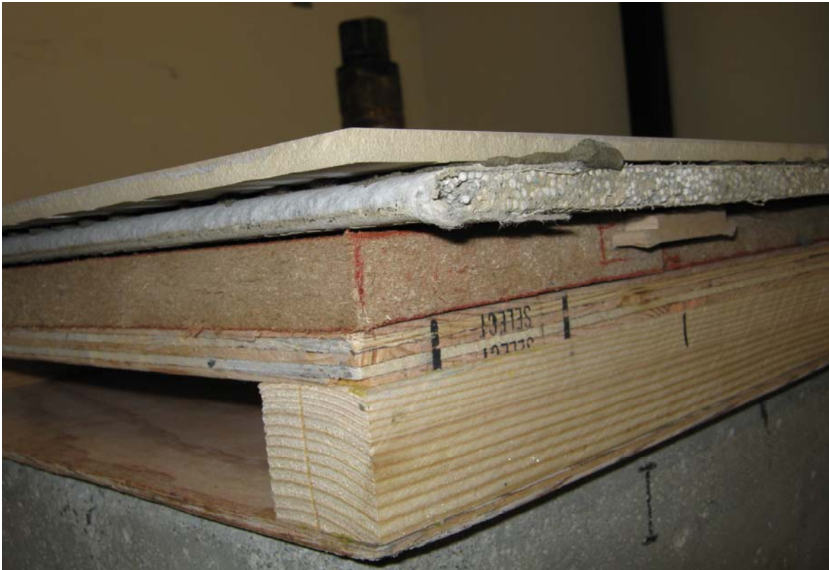
Figure 3 : Vue de côté du plancher assemblé.
