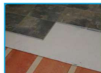
Jumelé SONO/MAX à un panneau de support (Fiberock, PermaBase, Durock) pour recevoir la céramique, le marbre, le granite.
